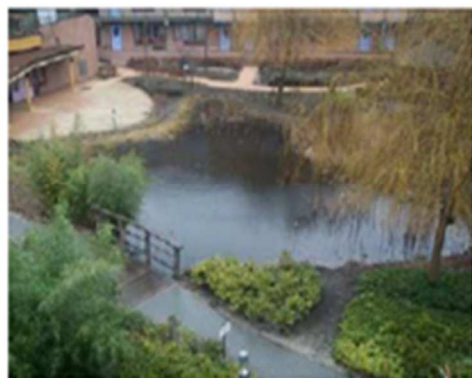
Figure 44 : Marre d'infiltration (Rombaut, 2010)
